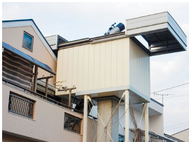
▲ 写真1. 上尾天体観測所の外観。南北開きのスライディングブルーフでベランダから階段を使って昇る。
