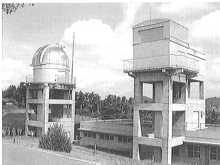
図1 美星スペースガードセンター ドーム内に1 m 望遠鏡、スライディングルーフ内に 50cm 望遠鏡が納められている。
